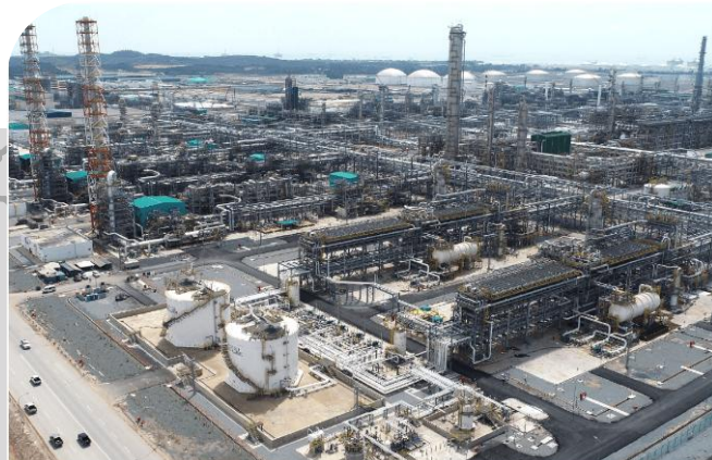
マレーシアPETRONAS社の敷地内に建設中
