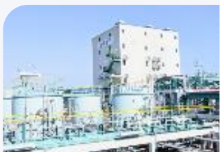
実証プラント*1
