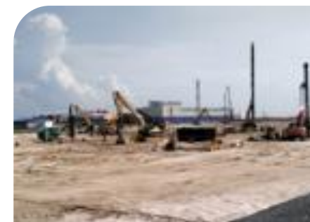
建設現場 (2025年6月)
