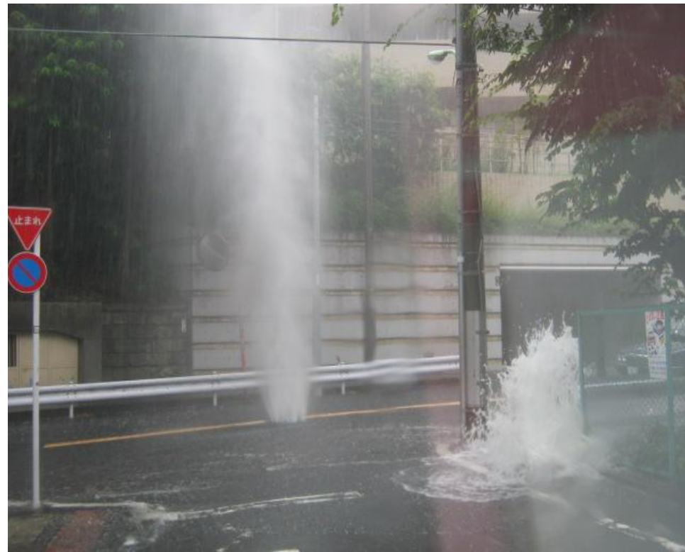
豪雨でマンホールから水が噴き上がる様子
