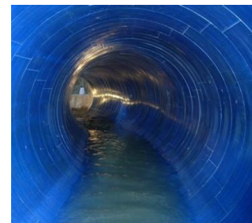
管路更生工事
