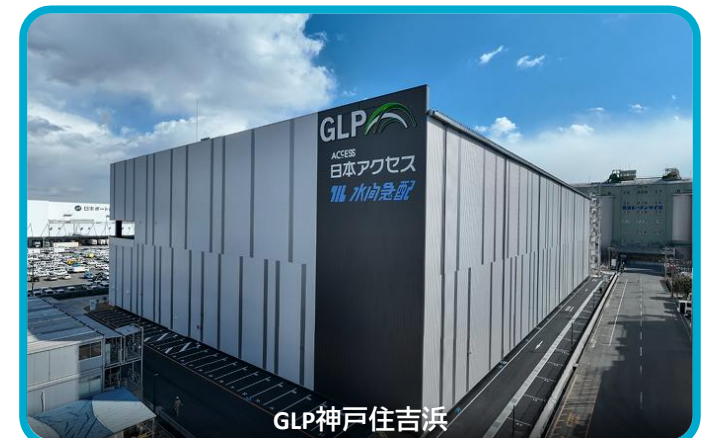
大型のマルチテナント型冷凍・冷蔵倉庫
