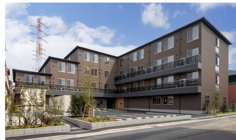
住宅型有料老人ホーム「Care Villa 川崎」
