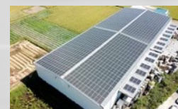
自家消費／武智発電所 容量：417.45kW
