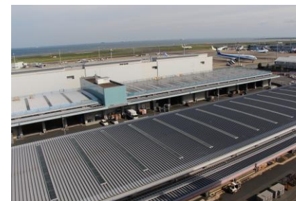
国内貨物地区太陽光発電設備
