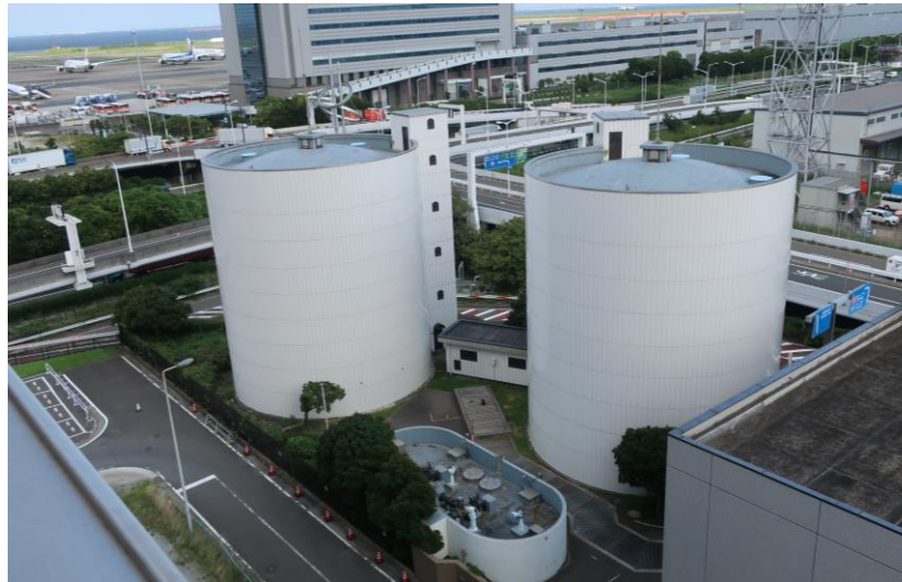
羽田空港給排水施設
