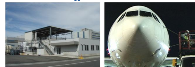
羽田空港大型航空機洗機施設
