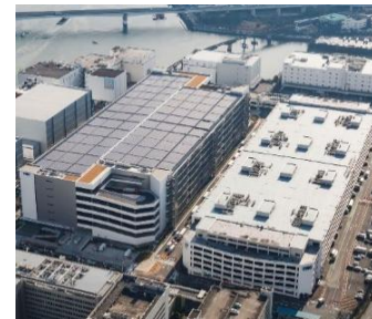
TRC物流ビルB棟屋根 ソーラー発電所
