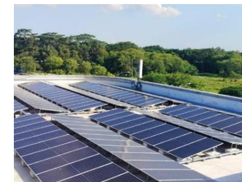
シンガポール・セレター空港 パイロット訓練施設
