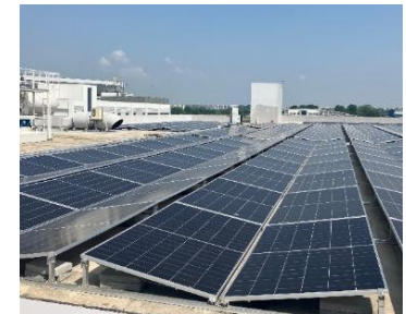
シンガポール・セレター空港 エンジン整備工場
