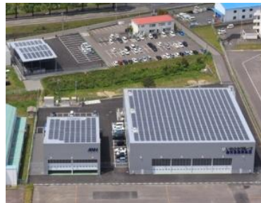
鹿児島空港 第一・第二格納庫及び倉庫
