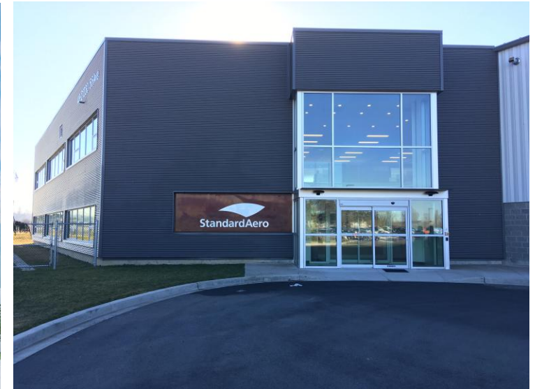
カナダ・ラングレー空港 ヘリコプター整備用格納庫
