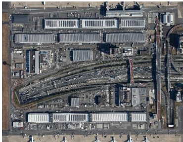
羽田空港 国内貨物ターミナル
