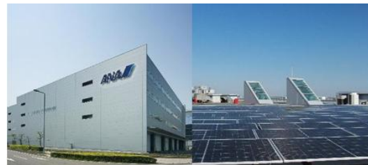
羽田空港 コンポーネントメンテナンスビル
