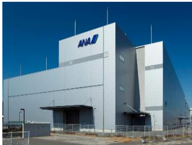
羽田空港 エンジンメンテナンスビル南棟
