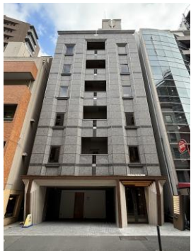
1棟事務所（千代田区）
