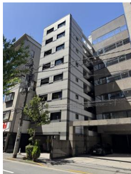
1 棟事務所（千代田区）
